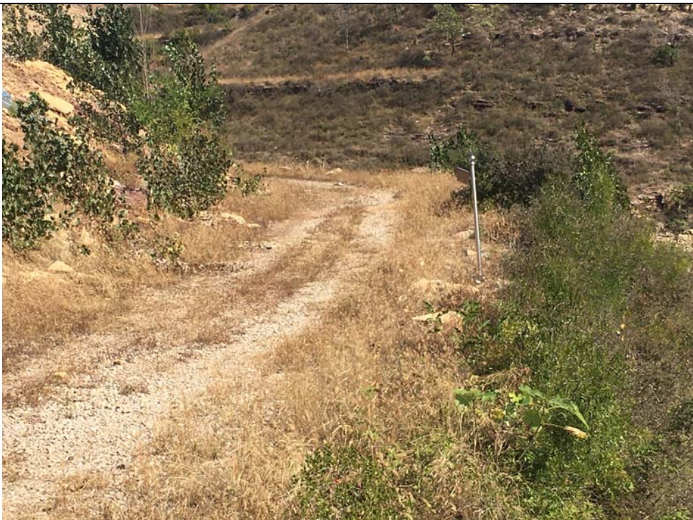
铺撒碎石措施
