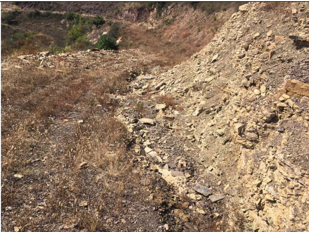
检修道路一侧临时排水沟
